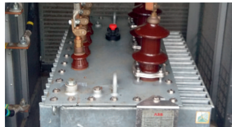
Bilderna visar en anläggning före och efter torrisblästring.
