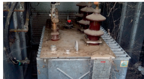
Bilderna visar en anläggning före och efter torrisblästring.
