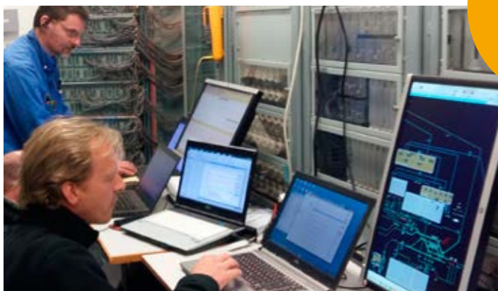
Vattenfall Services testar automatiken på en provinstallation.
