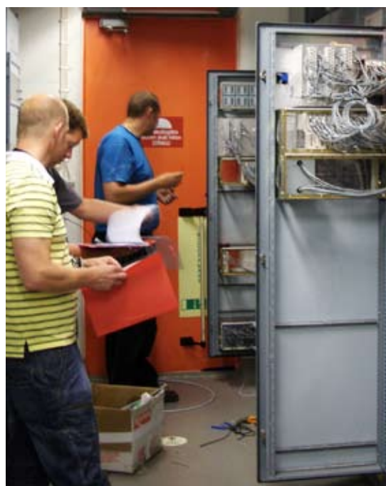
Arbete pågår i relärummet inför anslutning till det nya 400 kV-ställverket.
