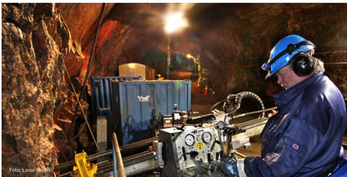
Provboringar runt SFR visar på ett bra berg med låga vatteninflöden.
