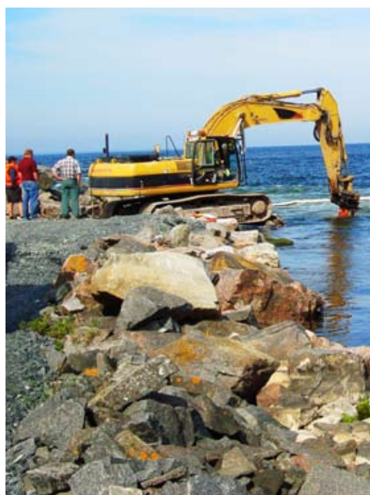
En tröskel vid Forsmark 3:s kylvattenutlopp tas bort för att öka kylvattenflödet inför en framtida effekthöjning.
