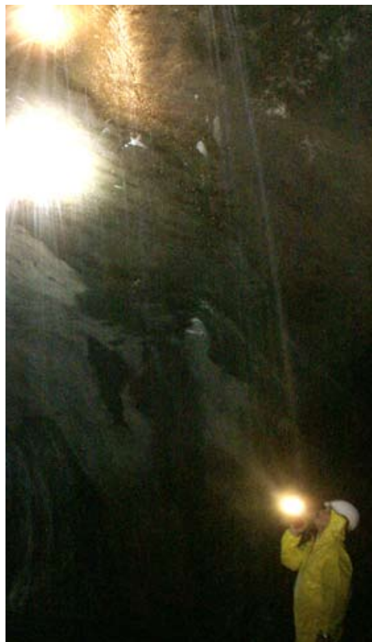
Besiktning av betongväggarna i kylvattenavloppet.
