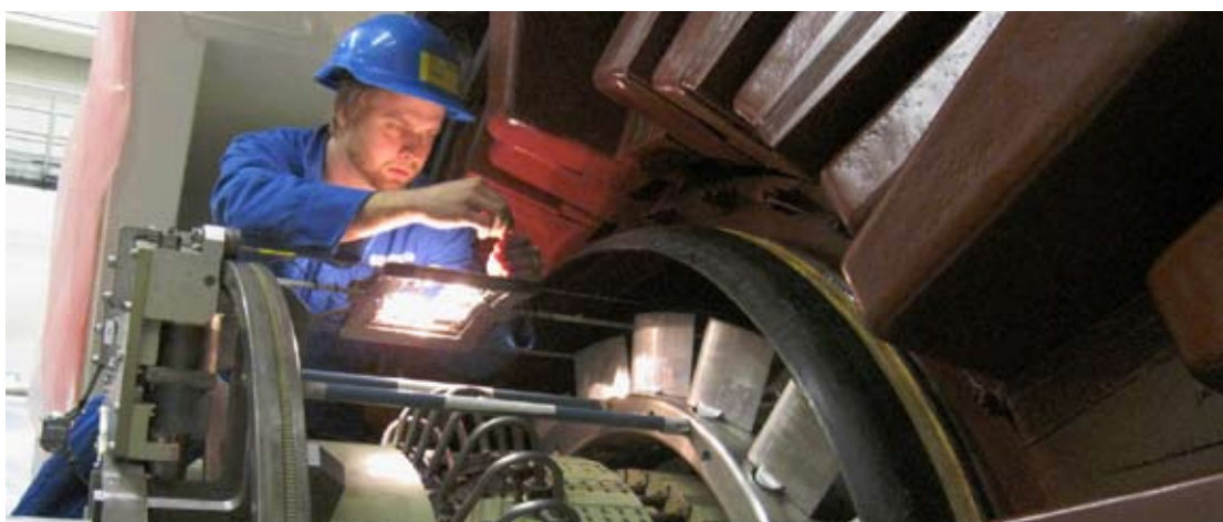
Paul Råmet kontrollerar att statorspårkilarna sitter bra i generatorn. Kontrollen sker med hjälp av en axialvagn som löper längs med generatorrotorn.
