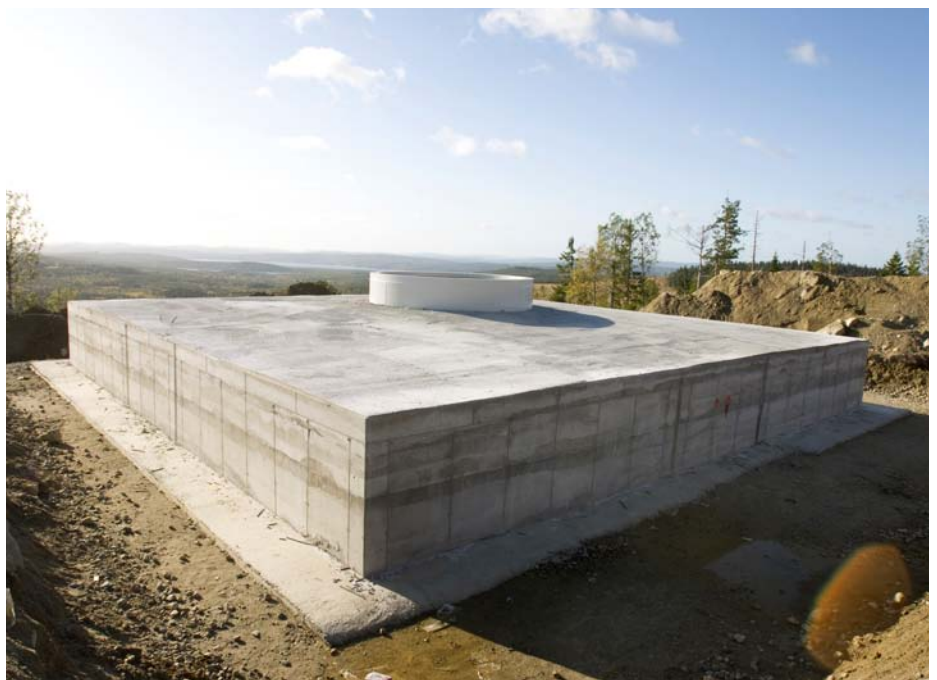
Gravitationsfundament i Stor-Rotliden i Åsele kommun.
