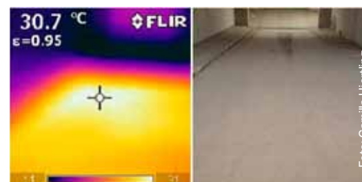
Termografering, där energiläckage syns med hjälp av en värmekamera, är ett bra verktyg för att identifiera potentialer till energieffektivisering.
