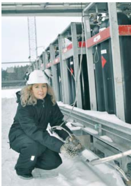
Catharina Boström, stationstekniker från skiftlag 7 på Forsmark 3, visar hur man fyller på vätska som kyler generatoren.
