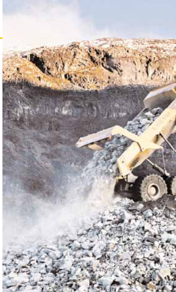
Förstärkning av kraftverksdammen i Suorva.
