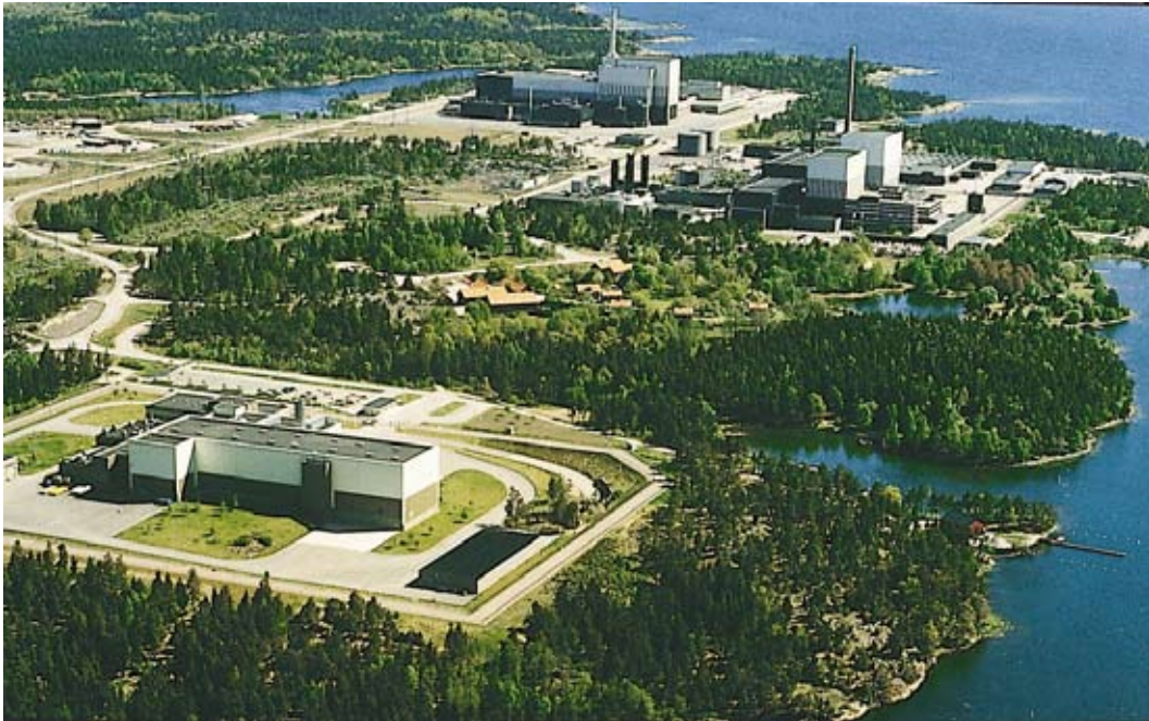
Figur 7.4. CLAB med kärnkraftverken Oskarshamn 1 och 2 i bakgrunden.
