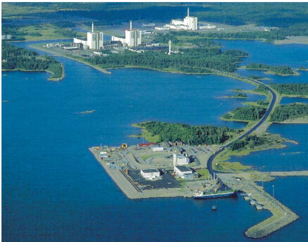
Figur 7.1. SFR mottagningsstation med Forsmarks tre kärnkraftblock i bakgrunden.
