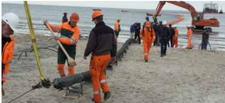
Förläggningsarbeten vid landningspunkten, Horns Rev, Danmark
