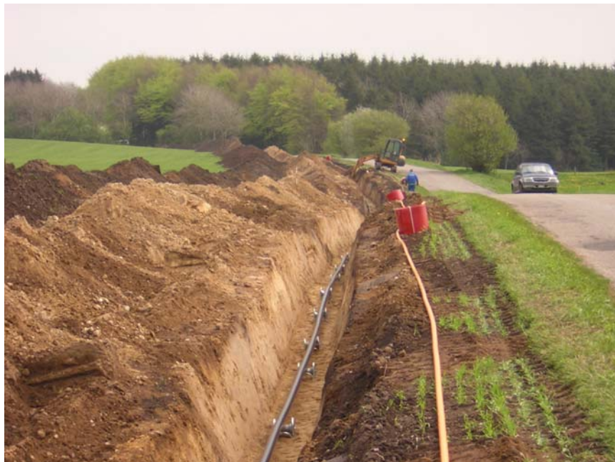
Kabelförläggning, Horns Rev, Danmark
