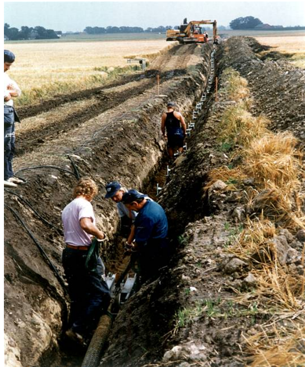
Kabelförläggning, Baltic Cable
