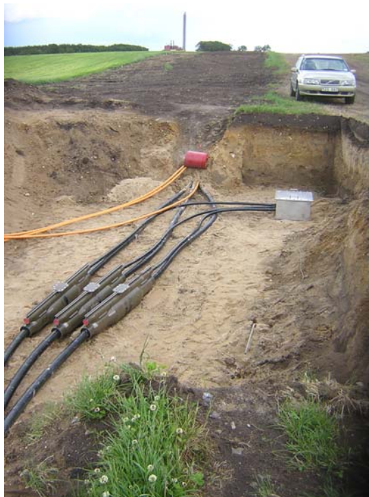
Skarvar och crossbondingbox, Horns Rev, Danmark
