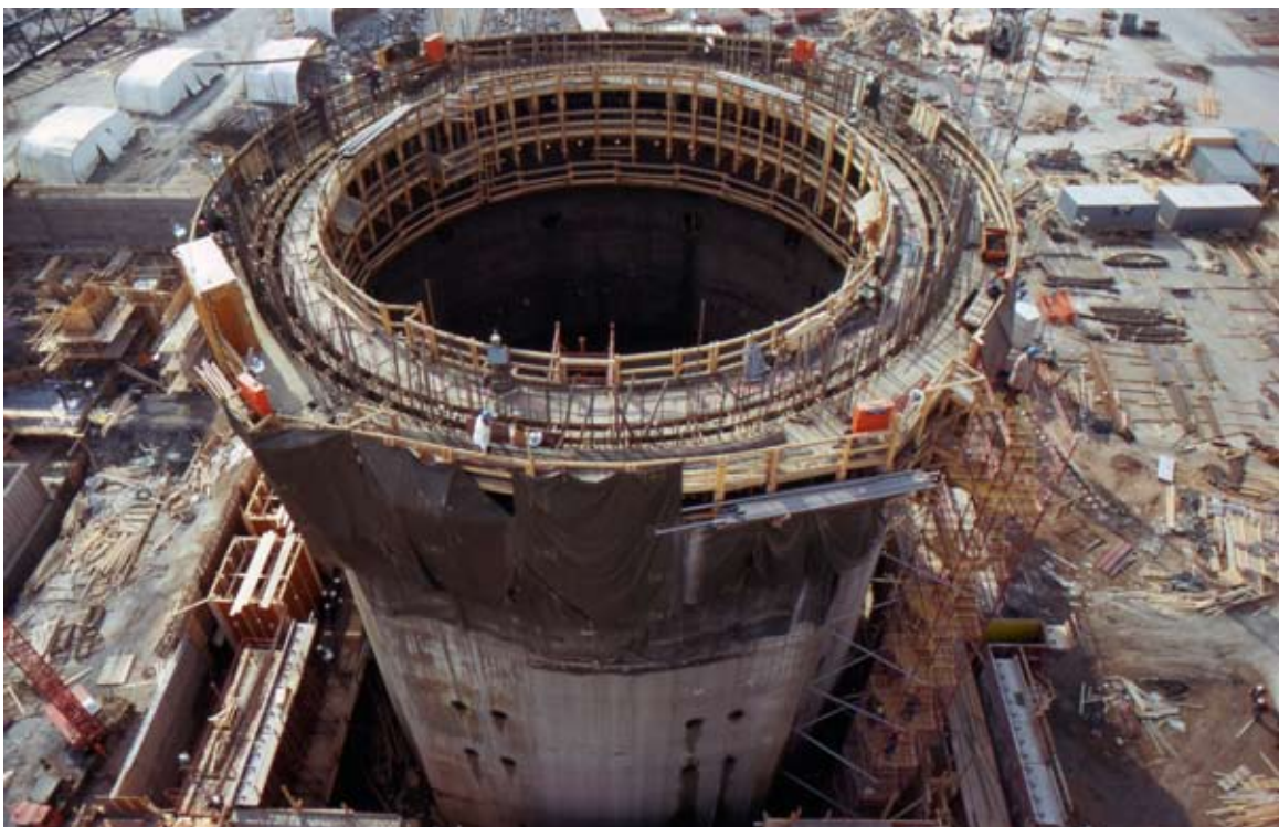
Forsmark 1:s reaktorbyggnad under uppförande 1974.
