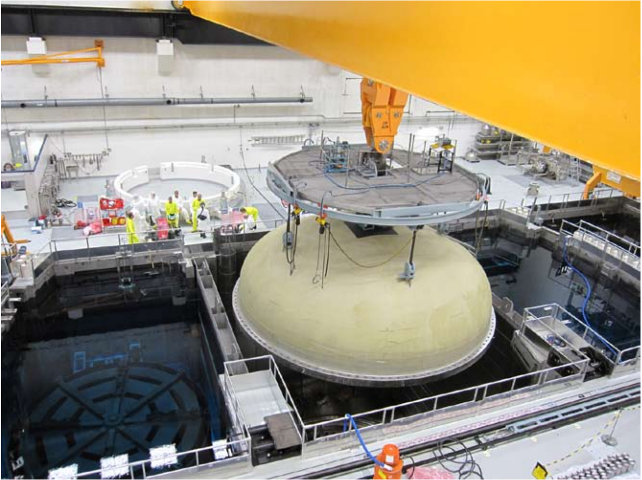
Reaktorinneslutningens lock, kallat kupolen, lyfts på plats under revisionen på Forsmark 2.
