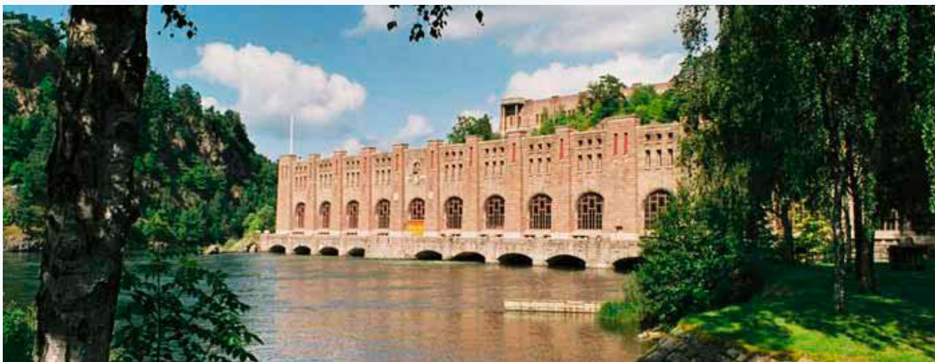
Olidan i Göta älv var ett av de första stora vattenkraftverken som byggdes 1909–1916 av nybildade Kungliga Vattenfallsstyrelsen.
